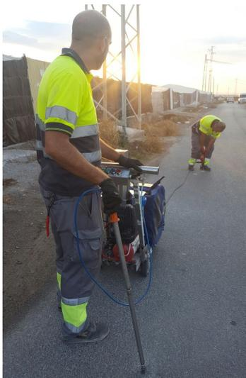
El Ayuntamiento de Adra, a través de la empresa concesionaria de aguas, Hidralia, ha iniciado una búsqueda de fugas en la red del municipio, utilizando técnicas avanzadas con gas Helio. Esta novedosa técnica, que pone en marcha por primera vez Hidralia en la provincia, permite la realización de los trabajos sin interrumpir el suministro a los ciudadanos, con total seguridad y con un mayor índice de eficacia.
