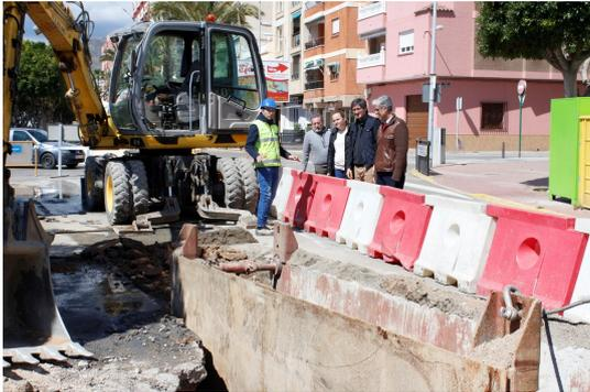
El Ayuntamiento de Adra, a través del servicio de aguas, Hidralia, está llevando a cabo nuevas obras de renovación de parte de la red principal de saneamiento. Estos trabajos, sustituirán un total de 66 metros longitudinales de la red existente, mejorarán su capacidad y servirán para prevenir malos olores. Para ejecutar la obra, que se desarrollará en dos fases, se destinará un importe cercano a 32.000 euros.
