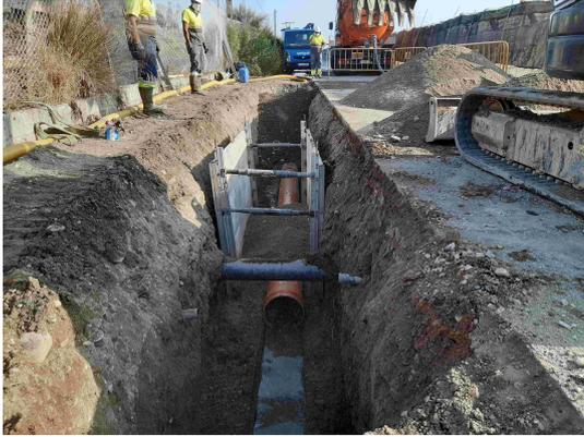
El Ayuntamiento de Adra, a través Hidralia, empresa gestora del Servicio Municipal de Abastecimiento de Agua y Alcantarillado, ha iniciado esta mañana la renovación de 34 metros de tubería en el camino de La Botella. Las obras de emergencia han comenzado tras detectar una rotura en la red de alcantarillado de la zona que recoge el agua residual de La Curva y Puente del Río.
