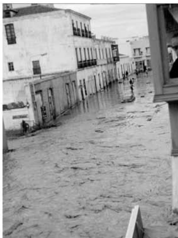
Confluencia de la carrera Natalio Rivas con la calle Carril de Cuenca. Buena parte del agua detiene su avance y toma el camino del puerto, arrasando el antiguo cine Casablanca
